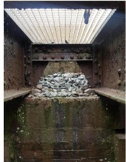
Figure 5 : Ligne 325 000 - Photographies des avaries du tablier métallique à poutres jumelles du PRa situé au PK 142+268
