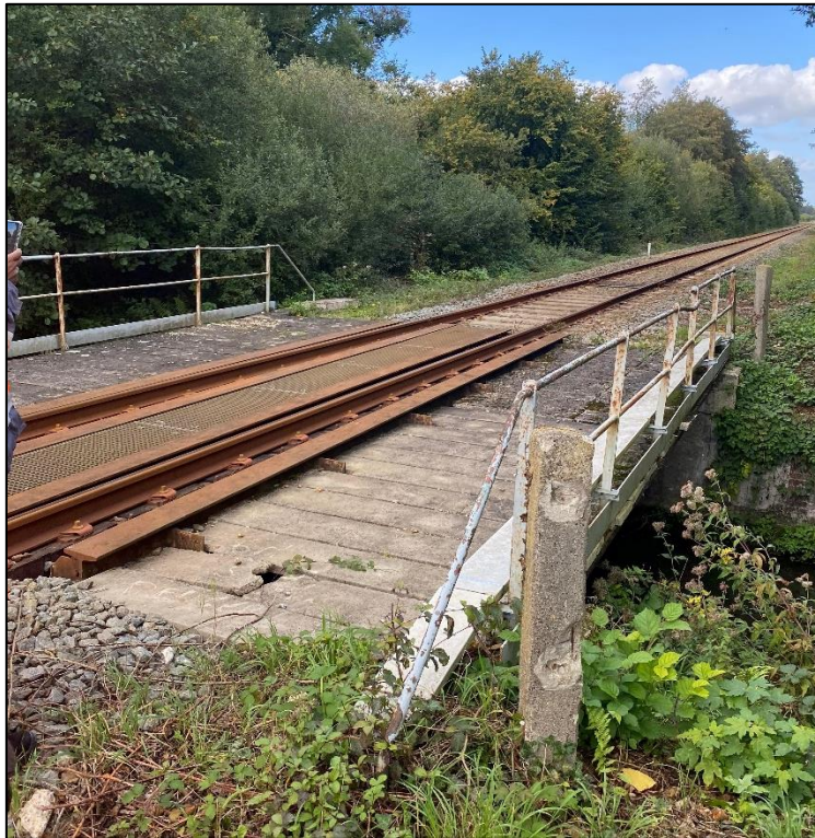
Figure 1 : Ligne 325 000 - Vue du dessus de l'ouvrage au Pk 142+268
