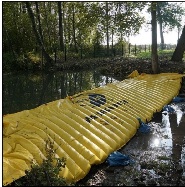
Figure 9 : Exemple de batardeaux de type Watergate
