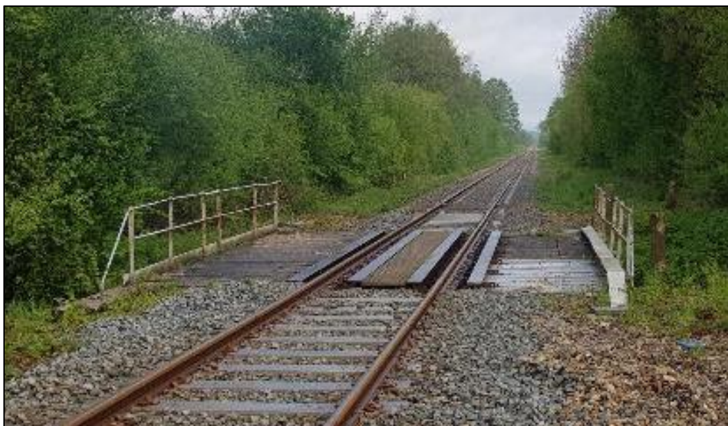
Figure 4 : Ligne 325 000 - Photographie de l'ouvrage situé au PK 142+268
