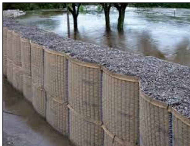
Figure 8 : Exemple de batardeaux de type big-bags
